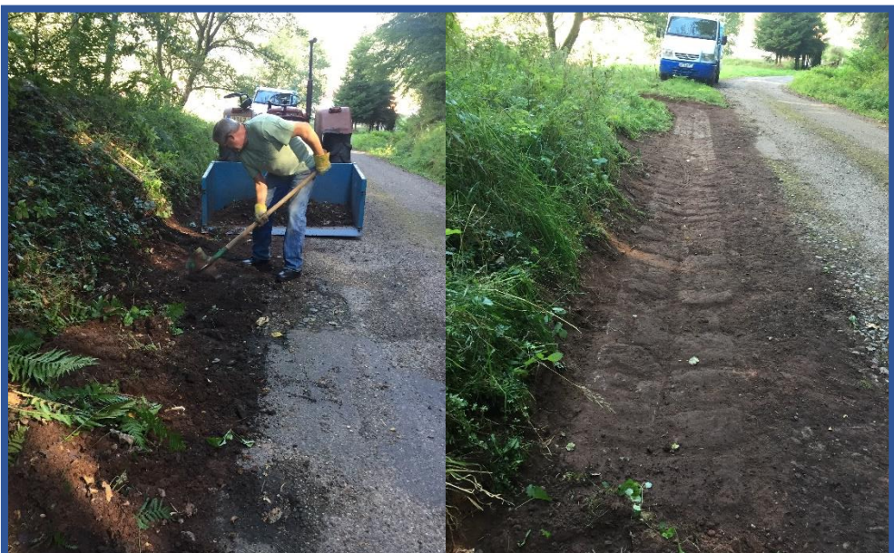
Nettoyage des caniveaux, rue de Lambach
