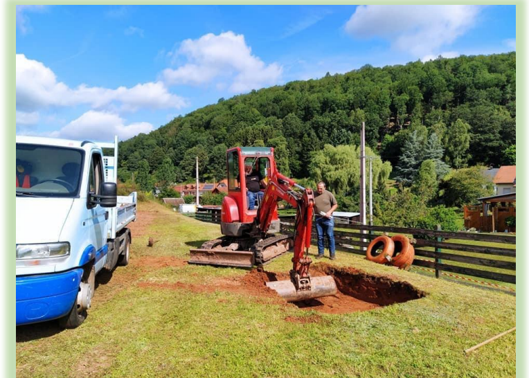
Terrassement de l'aire de jeux par Raphaël et Jacky pour pouvoir sceller les jeux au sol
