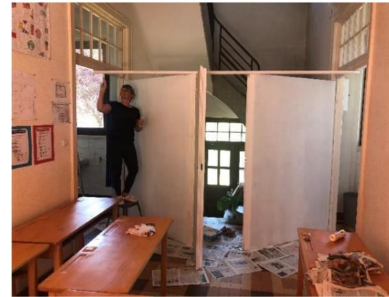
Mise en place d'une cloison dans le couloir de l'école entre les appartements du haut et les salles de classe.
